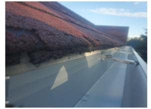
2. Le rejet d'eau de la vallée (dans les coins intérieurs) est trop court par rapport à la corniche ou inexistant, donc l'eau ne se rend pas correctement dans la gouttière. (l'eau s'écoule donc entre la gouttière et la corniche.)
